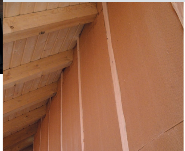
Isolation en fibres de bois avant la pose d'un coupe-vent et d'une façade ventilée.
