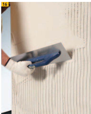
Enduisage du treillis d'armature
