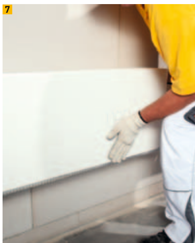
7 Poser le panneau isolant minéral Multipor
