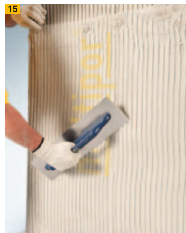
Pose du treillis d'armature
