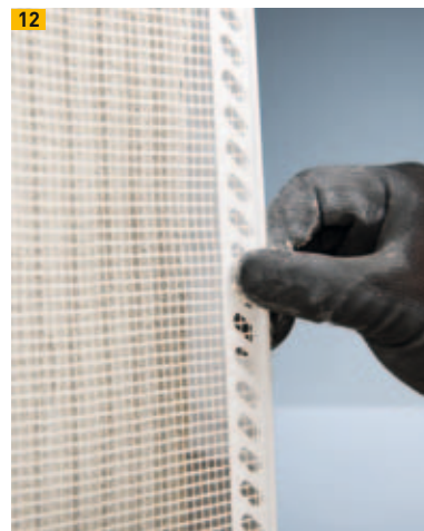
Profilé d'angle sur l'angle extérieur
