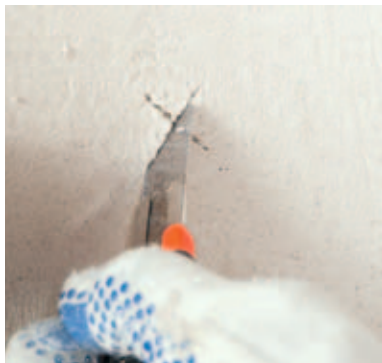
Découpe treillis pour percement/pose cheville spirale
