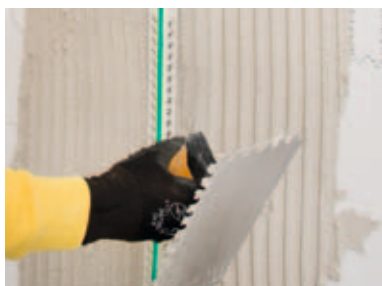
Profilé de joint de dilatation
