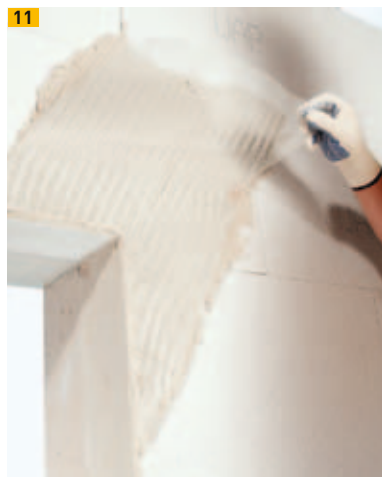
Tissu d'armature sur l'ouverture de fenêtre
