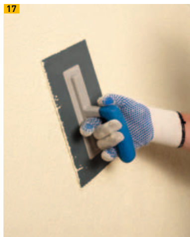
Structuration de l'enduit de finition
