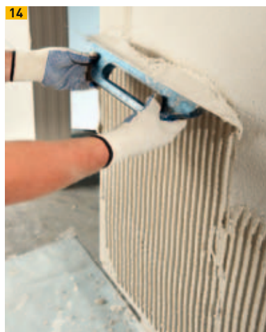
Application du crépit d'armature
