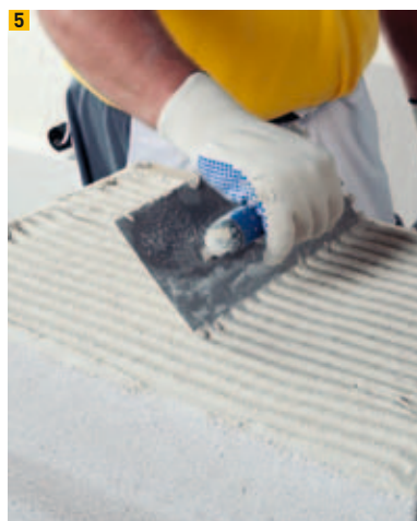
5 Application du mortier léger Multipor sur le panneau isolant
