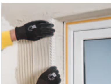
Profilé d'angle avec treillis Multipor
