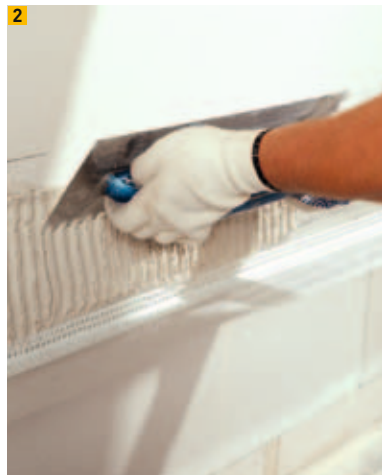
2 Soubassement avec cornière d'angle
