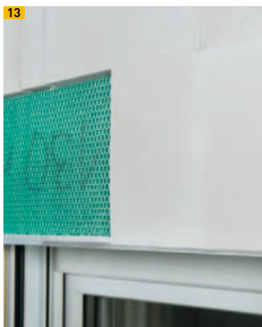
Isolation pour coffres de volets
