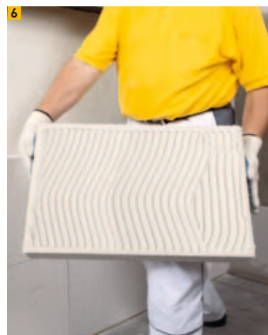
6 Application du mortier sur toute la surface
