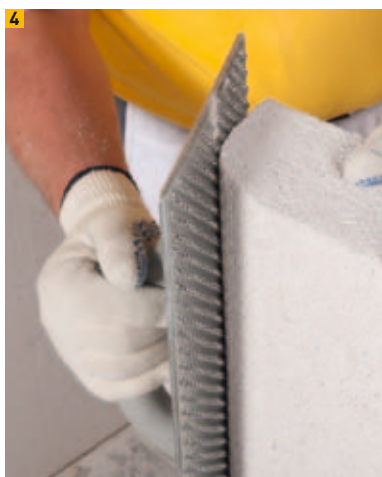
4 Adaptation du panneau isolant
