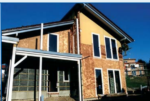
Holzständerhaus Neubau, Hameln
