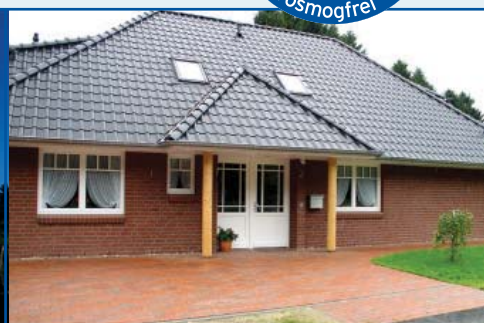
Viebrockhaus, Massivhaus, Hamburg
