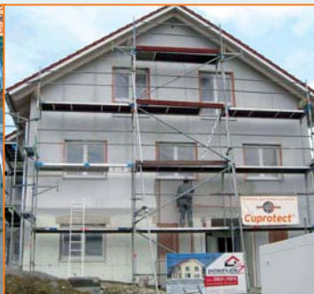
Vollwärmeverbundsystem Trockenbau oder ins Klebemörtelbett im Wärmedämmsystem
