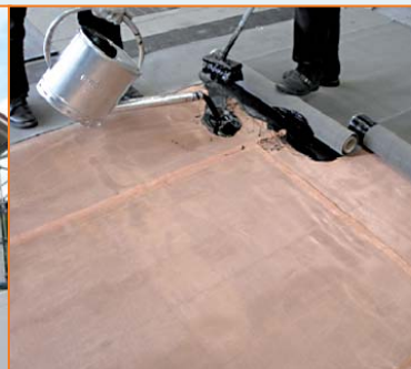
Flachdach Durchdringungsfreie Verlegung in Heissbitumen
