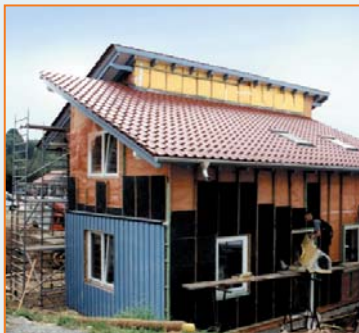
Holzständerbau Innenwände, Fassade und Dach
